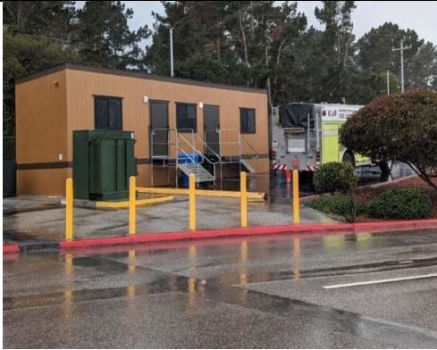
Remolque modular "parque de bomberos" en el aeropuerto
