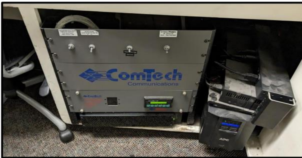
Sistema de alerta de despacho asistido por ordenador en el parque de bomberos 12 de Monterey Fuente: Fotografía tomada por el Gran Jurado Civil
