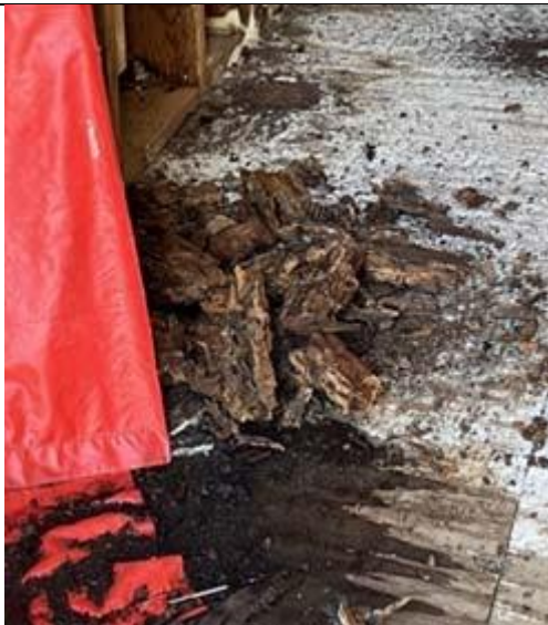
Vista del interior de la torre de entrenamiento abandonada
