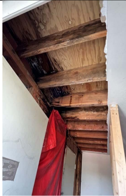
Vista del interior de la torre de entrenamiento abandonada
