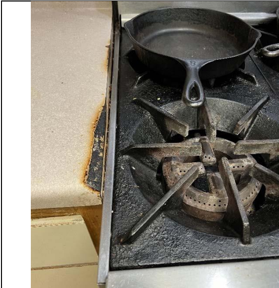
Daños en la vieja cocina/encimera
